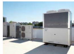
2012 Nuevas unidades GHP. Los sistemas VRF accionados a gas de Panasonic resultan ideales para proyectos en los que existan restricciones de consumo energético.
