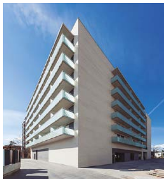
Nuevo edificio de 84 apartamentos en Cornellà de Llobregat, Barcelona. Aquarea
