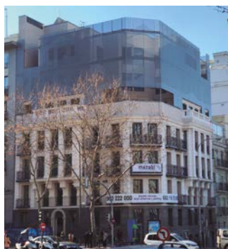
Oficinas en Calle Velazquez. Climatización de oficinas comerciales de tres plantas en Madrid, España. VRF Eléctrico
